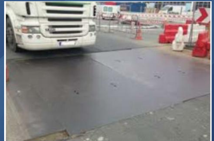
Exemple de plaque acier sur tranchée pour rétablissement du passage
