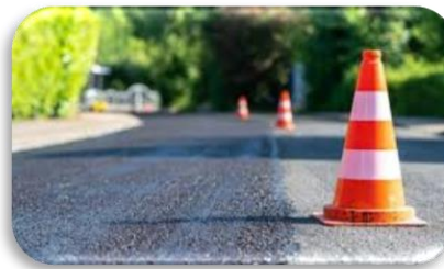
Voirie, panneaux, radar et trottoirs 180 K€
